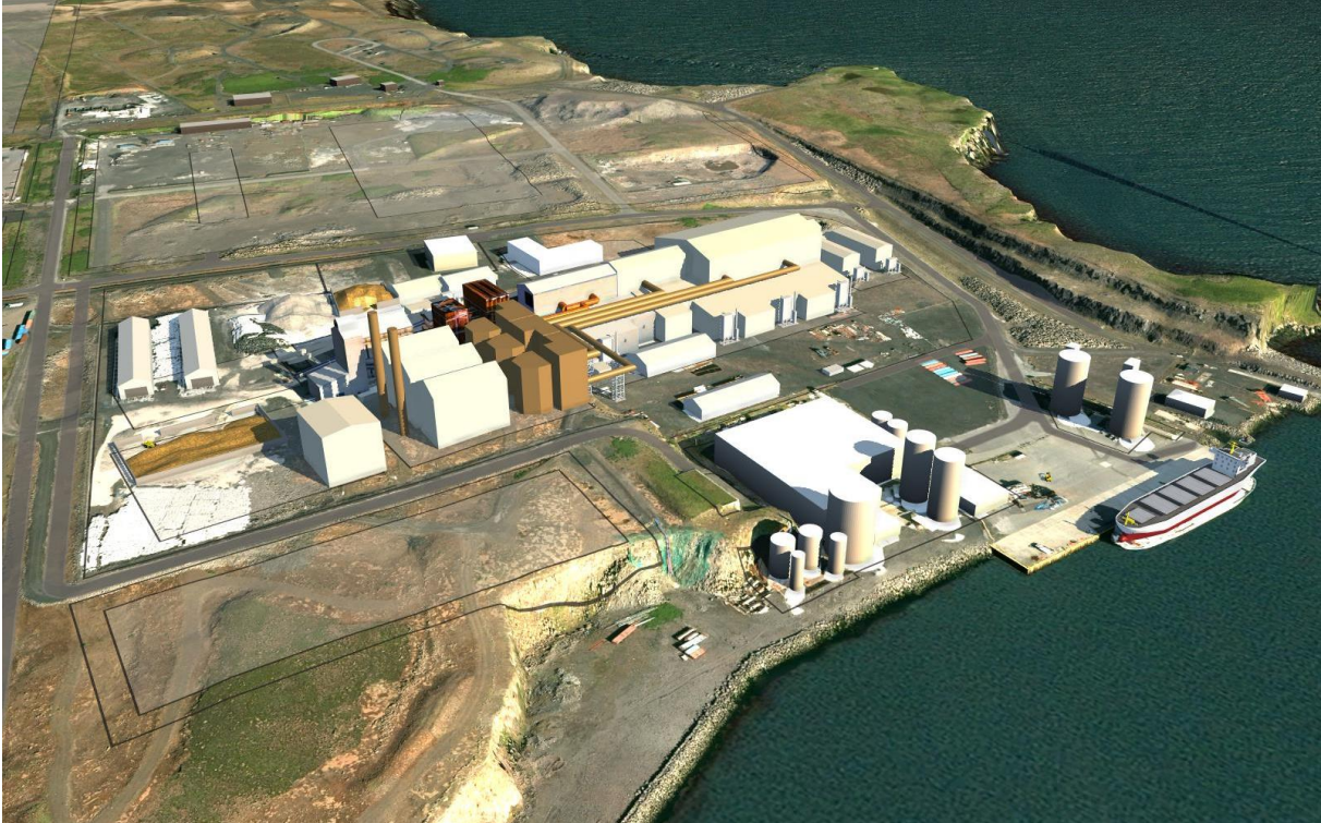
Mynd 5.5 Líkan af fullbyggðri verksmiðju með 4 ofna. Einnig sést líkan af núverandi mannvirkjum á öðrum lóðum við höfnina í Helguvík. Líta ber á mannvirki framtíðaráfanga sem skematíska framsetningu á áætlaðri stærð þeirra. Framtíðarbyggingar eru sýndar í hvítum lit en búnaður sem yrði úr stáli, s.s. loftkælar, forskiljur og skorsteinar, sýndur í brúnum lit.
