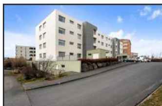
LÓMASALIR - 2. HERB. - STÆÐI Í LOKADRI BÍLAGEYMSLU
