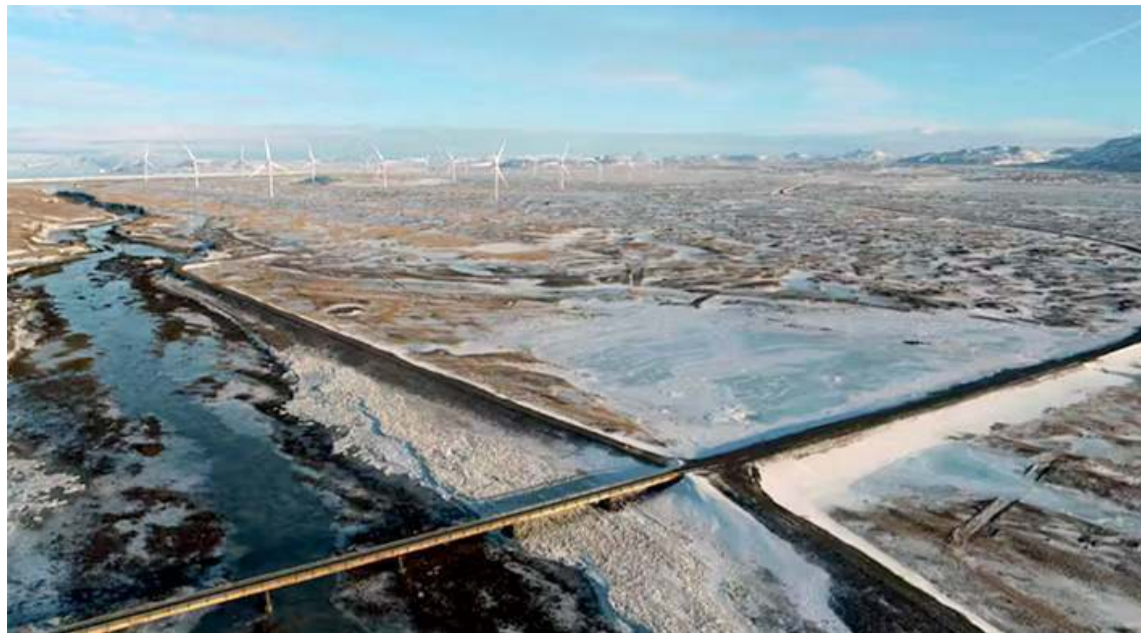
Í Búrfellslandi er gert ráð fyrir allt að 30 vindmyllum, hverri með 4-5 MW uppsett afli og samanlagðri orkugetu um 440 GWst á ári. Landsvirkjun hefur ákveðið að fara í útboð á vindmyllunum.
